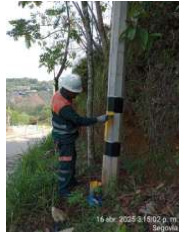
Demarcación de poste
