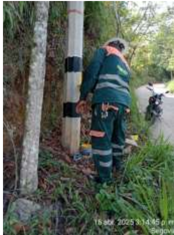
Demarcación de poste
