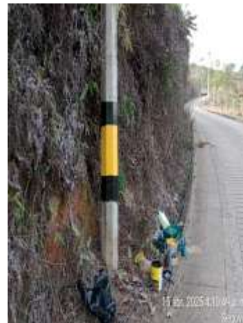
Demarcación de poste
