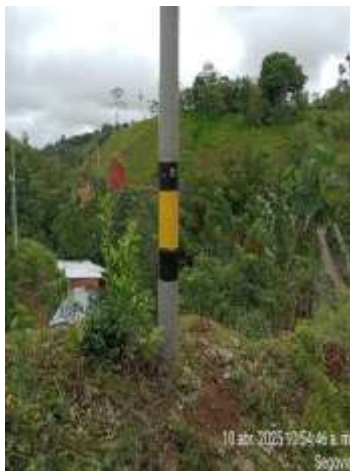
Demarcación de poste
