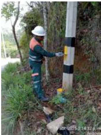
Demarcación de poste
