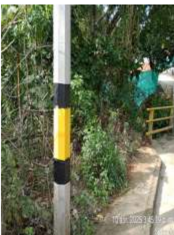
Demarcación de poste
