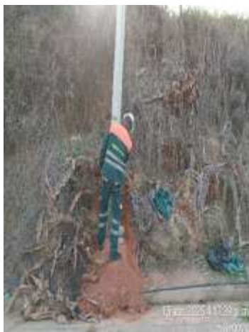
Demarcación de poste
