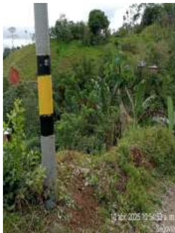
Demarcación de poste
