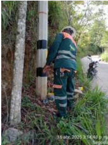
Demarcación de poste
