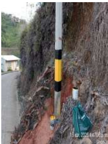
Demarcación de poste
