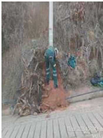
Demarcación de poste
