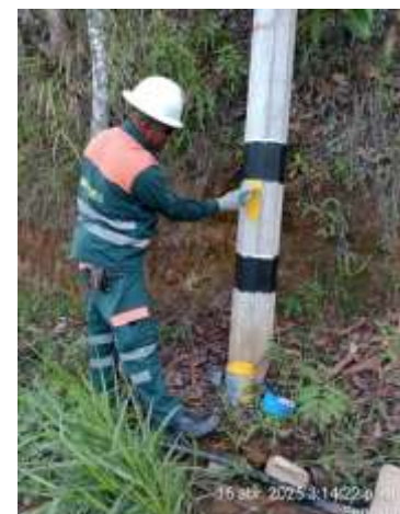
Demarcación de poste
