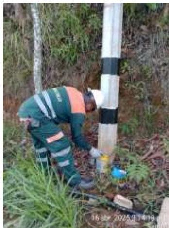
Demarcación de poste
