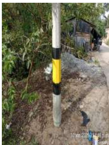
Demarcación de poste
