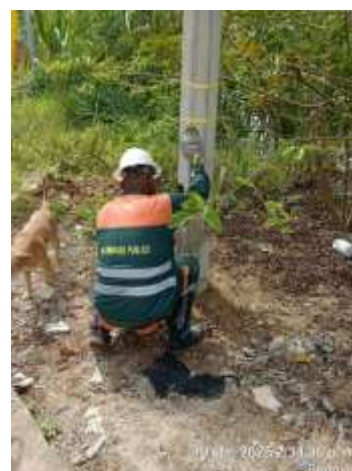
Demarcación de poste
